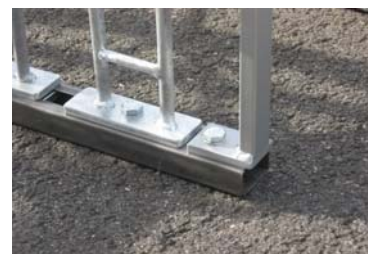
Part. Per fissaggio p.bici e telaio porta cartello ai binari
