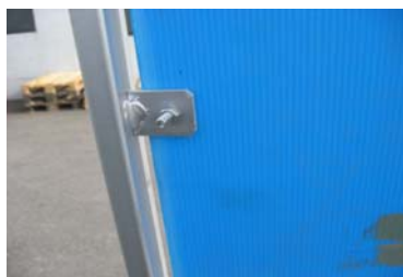
Part. Per fissare il cartello pubblicitario al telaio
