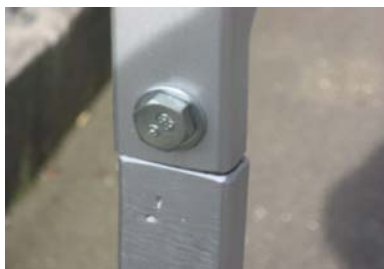
Part. Per fissaggio telaio porta cartello
